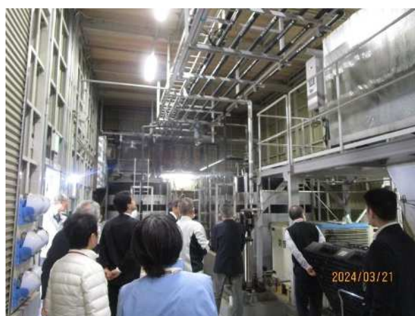
廃水処理施設視察
